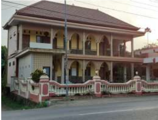
Gambar 4.7. Gedung TPQ Roudhotul Mujawwidin
