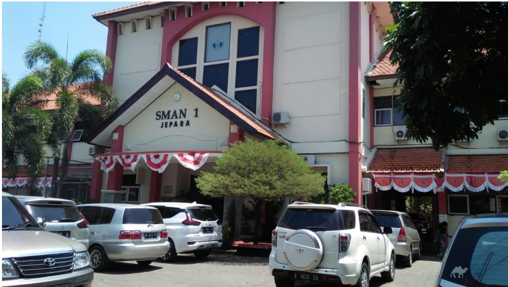
Gedung Perpustakaan SMA Negeri 1 Jepara
