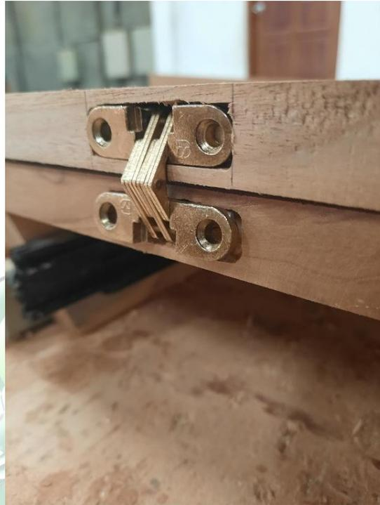
Gambar 90. Konstruksi daun meja model *flip top*
