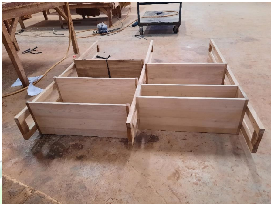
Gambar 68. Perakitan rangka Sumber : Dokumentasi Penulis, 2021
