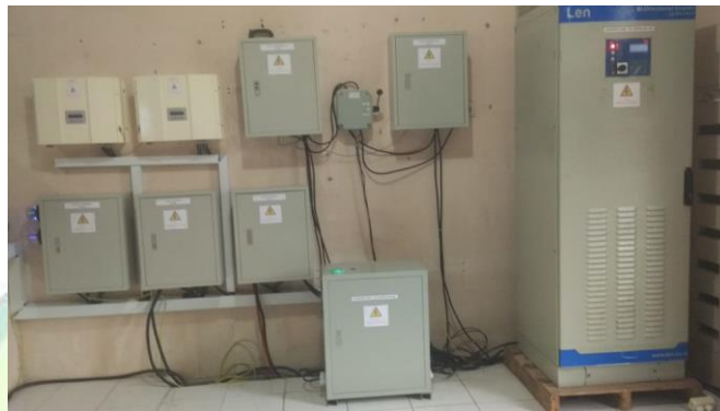
Gambar 2.6 Inverter 5 KVA PLTH Bayu Baru
