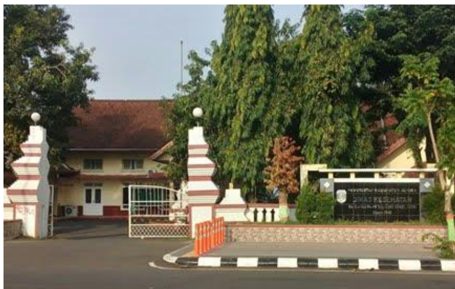
Gambar 3.2 Gedung Dinas Kesehatan Kabupaten Jepara
