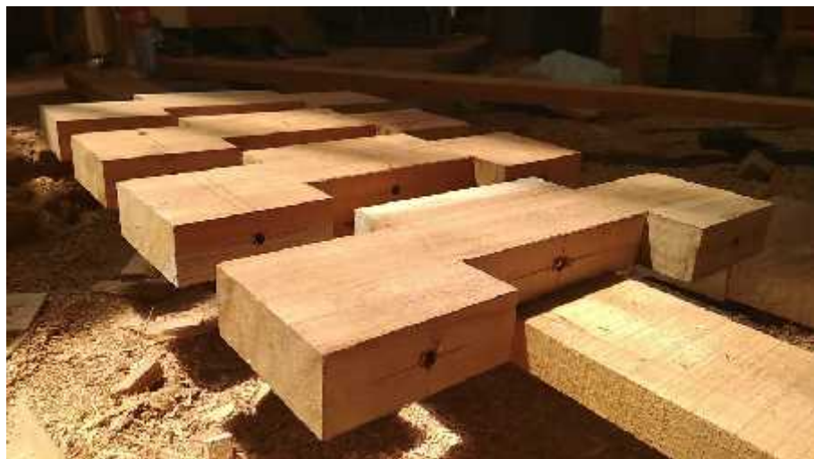
Gambar 80: Proses pembuatan kontruksi (Sumber: Penulis)
