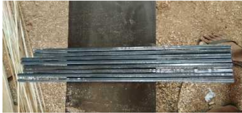
Gambar 81: Proses pembuatan kontruksi (Sumber: Penulis)
