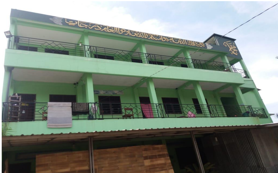
Gedung MTs. Daarusy Syifa Ploso Jati Kudus
