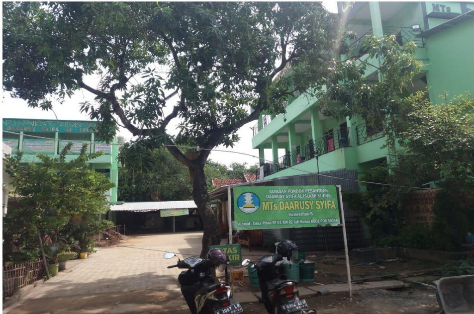
Gedung MTs. Daarusy Syifa Ploso Jati Kudus
