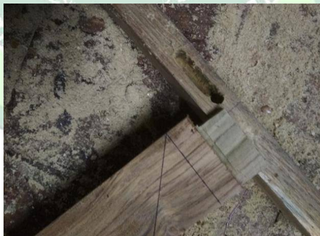
Gambar 4. 14: Detail Konstruksi Purus
