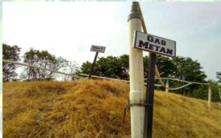
Gambar 2.7 Pemipaan gas metan dalam proses *sanitary landfill*
