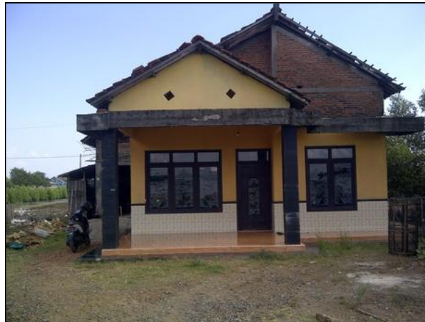
Gambar 28 Rumah informan Halimi sebagai lokasi penelitian (sumber: dokumentasi penulis)
