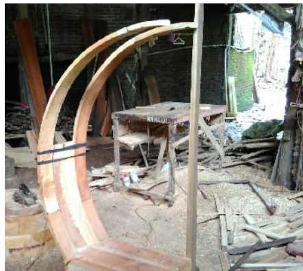
Gambar 64: Pembuatan Konstruksi (Sumber : Penulis)
